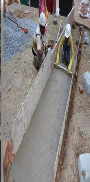
Green Concrete Pouring & Leveling
